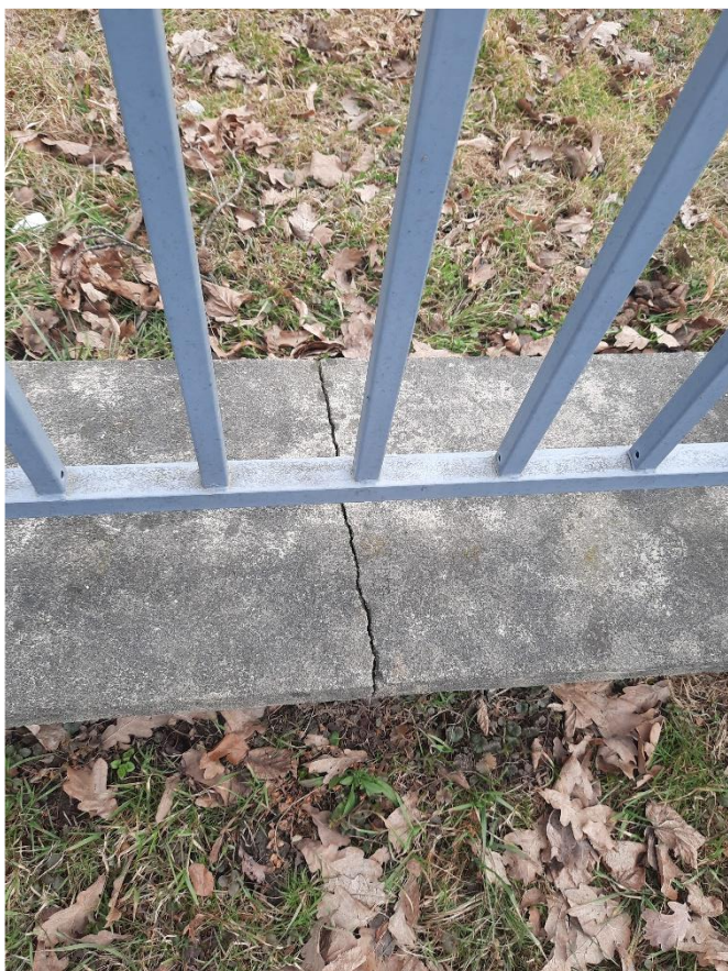
Rys.3 – Betonowe okapniki podmurówki do czyszczenia, uszczelnienia i impregnacji
