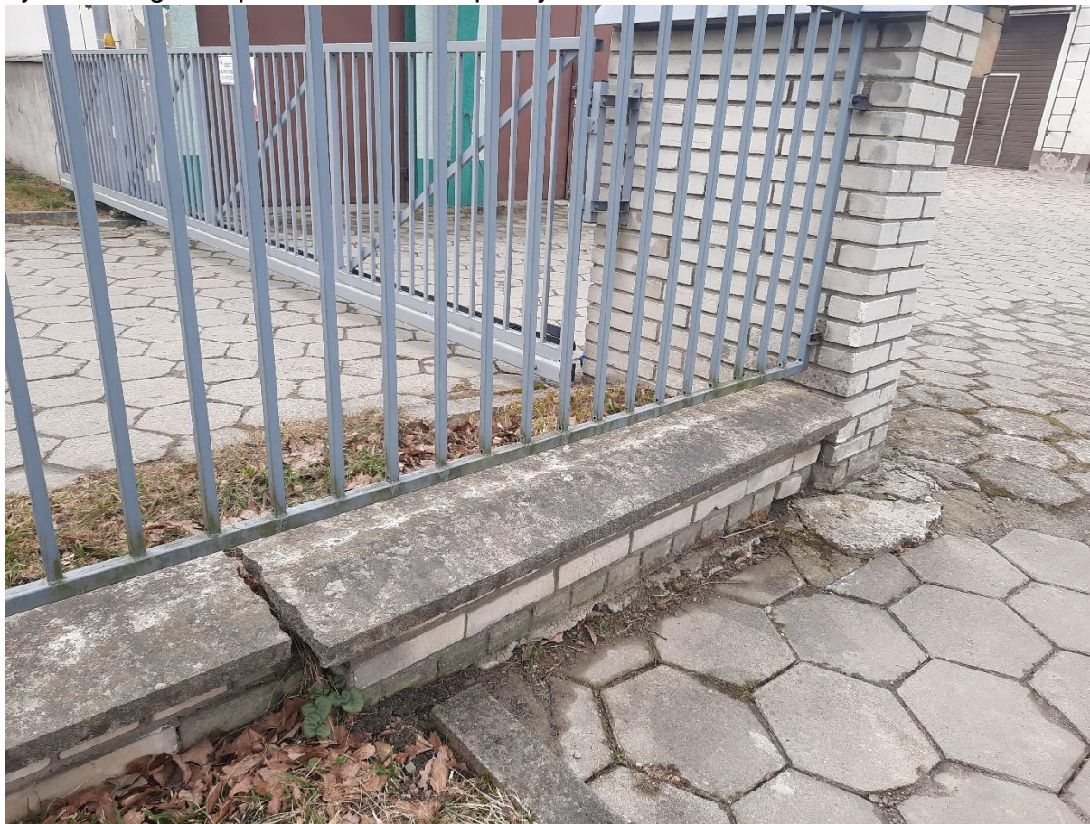
Rys.3 – Betonowe okapniki podmurówki do czyszczenia, uszczelnienia i impregnacji
